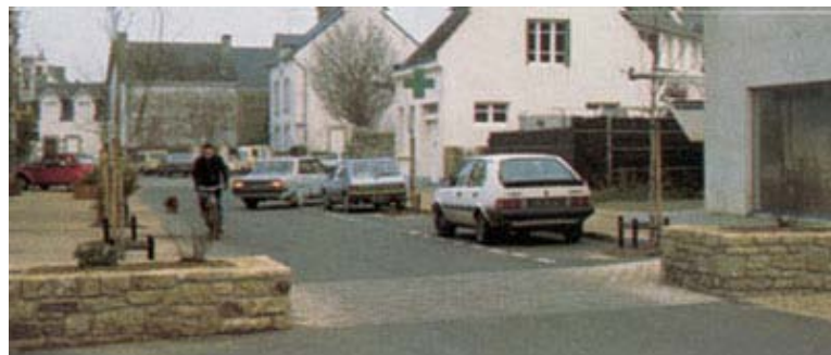
Figura 29 – esempio di restringimento puntuale della carreggiata
